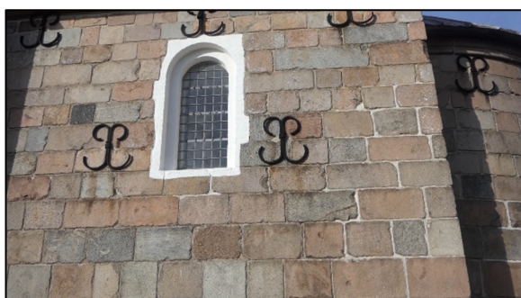
Kirkens kor, hvor det ses, at de største kvadre er anbragt nederst med undtagelse af K7, der ses under murankret
