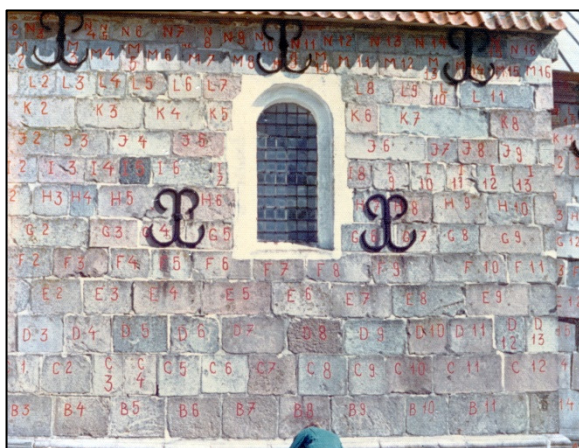
Kvadrene flot og omhyggeligt nummererede med rød maling, bemærk igen K7
