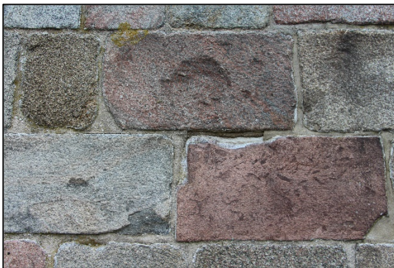
Kvadermuren fuget med kalkmørtel
