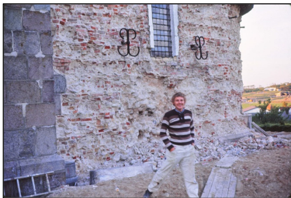
Murersvend Søren Thrøysø efter kvadrene er taget ned og noget af murkernen er borthugget
